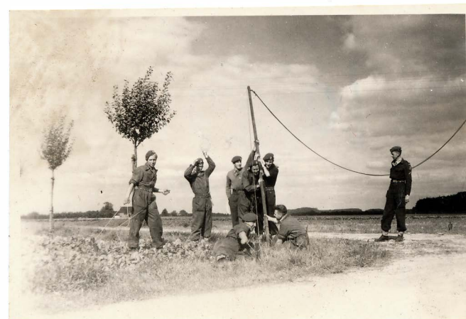
Een telefoonkabel via palen over een weg aanleggen. Sergeant Harry keek toe.
